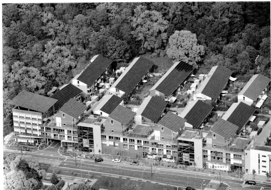
道路側から見たソーラー団地
